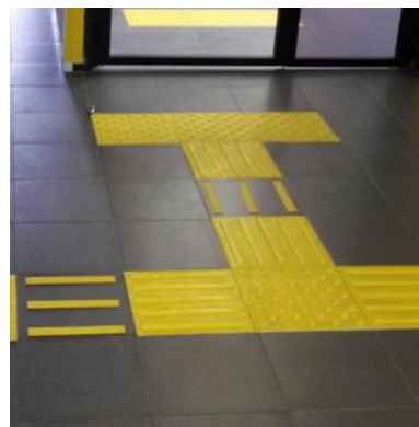
Рисунок 1. Форма рифления - прямолинейные параллельные рифы с плоской вершиной, используемые для обустройства предупреждающих ТНУ перед выходом с тротуара на пешеходные переходы и при пересечении местных проездов
